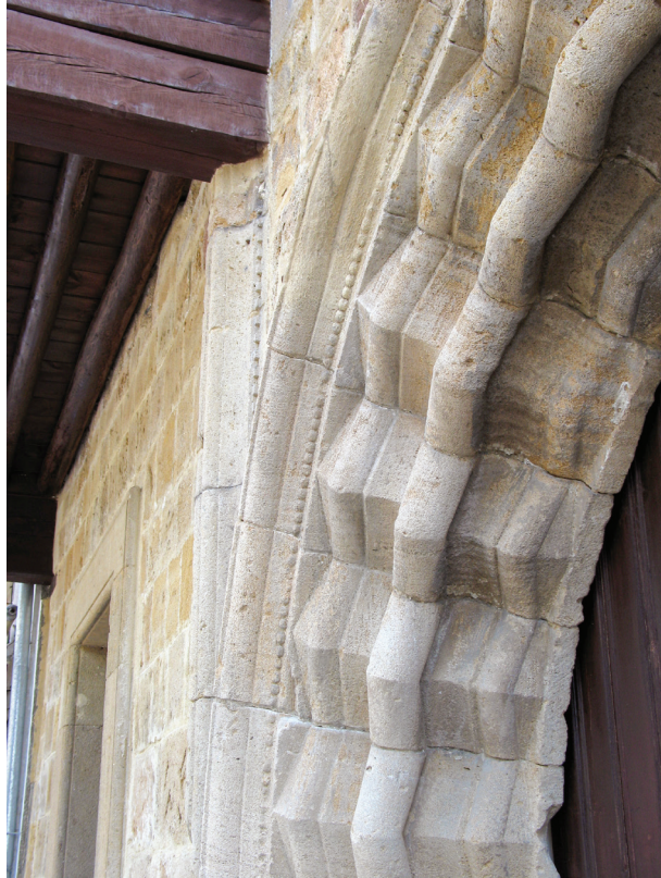
Εικόνα 5: Επανάχρηση αψίδας σε εξώπορτα στην περιοχή της Κάτω Πλατείας (Φωτογραφία του συγγραφέως).
