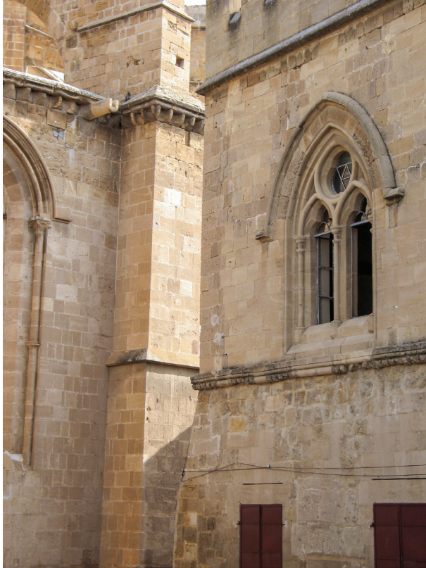
Εικόνα 12: Αγία Σοφία: Επισκοπικό κτίσμα (;) νότια του Λατινικού Καθεδρικού (Φωτογραφία του συγγραφέως).
